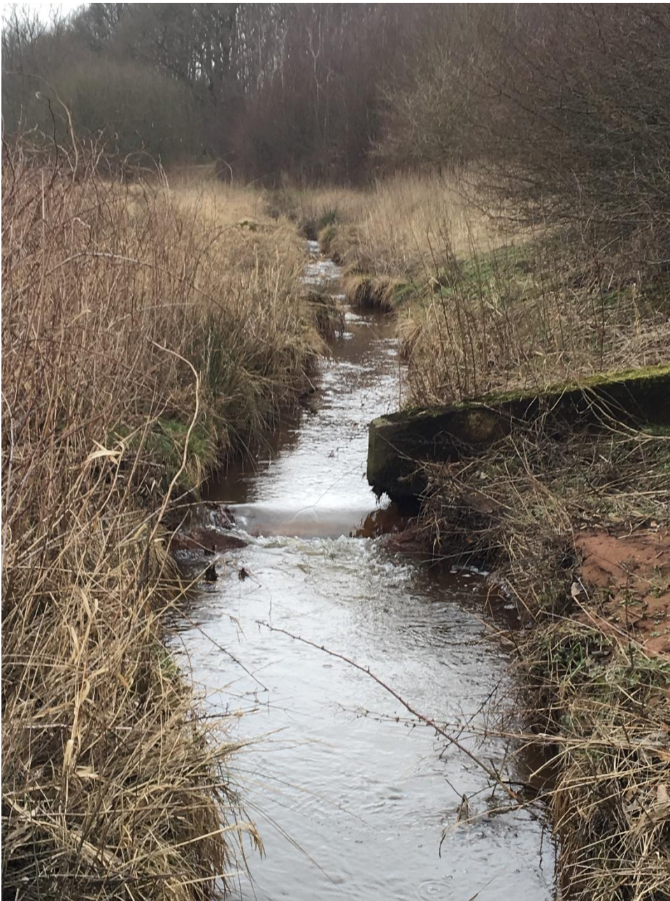
Figur 12. Station 3069m er eget til grusudlægning omkring gl. betonstøt.
