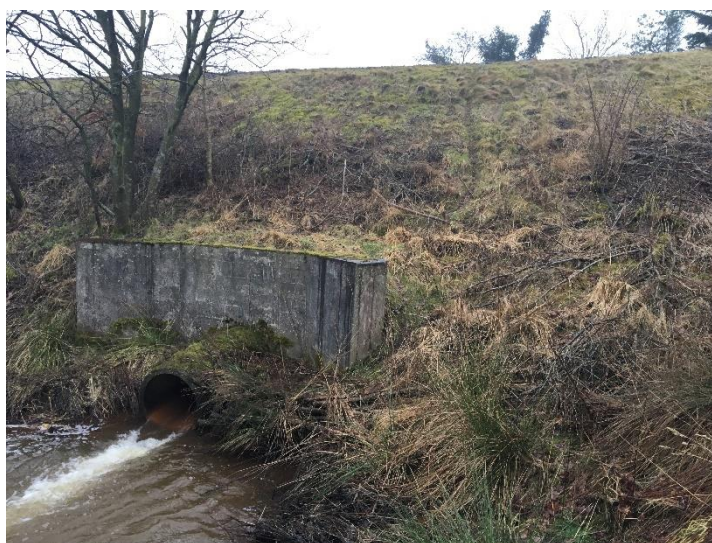
Figur 2 Spærring ved jernbane
