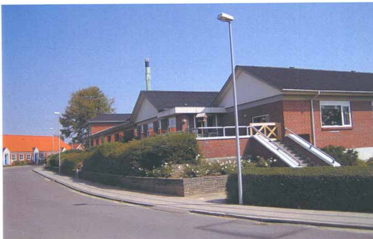
Det eksisterende plejehjem set fra Enghavevej.
