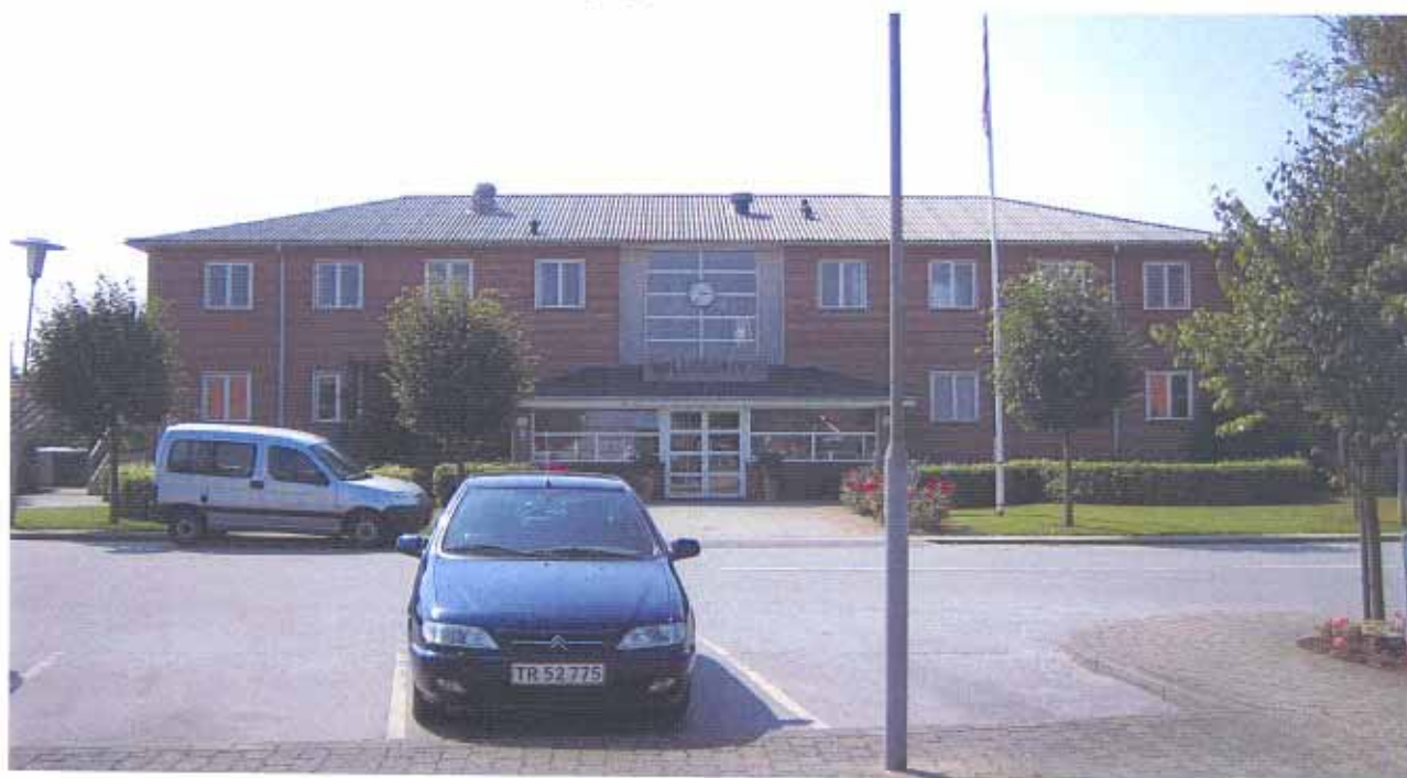
Det eksisterende plejehjem set fra Storegade.
