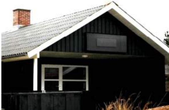
Solenergianlæg placeret i gavltrekanen
